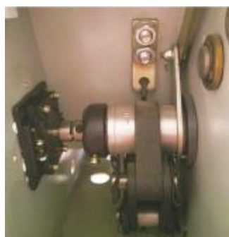
图 2 角位移传感器在 VS 1 断路器上的安装示意图
