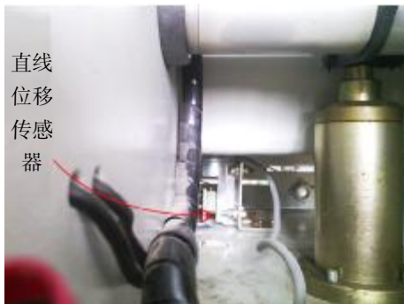
图5 直线位移传感器在 VS_1 断路器上的安装示意图
